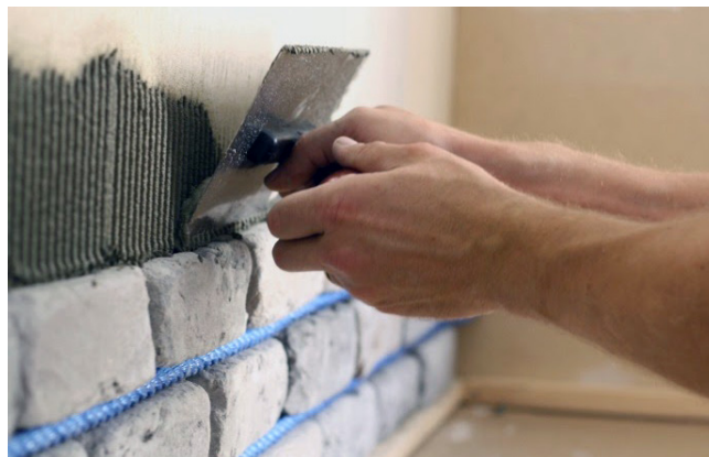
Käytä laastin levitykseen 8-9 mm piikkistä laastikampaa.
