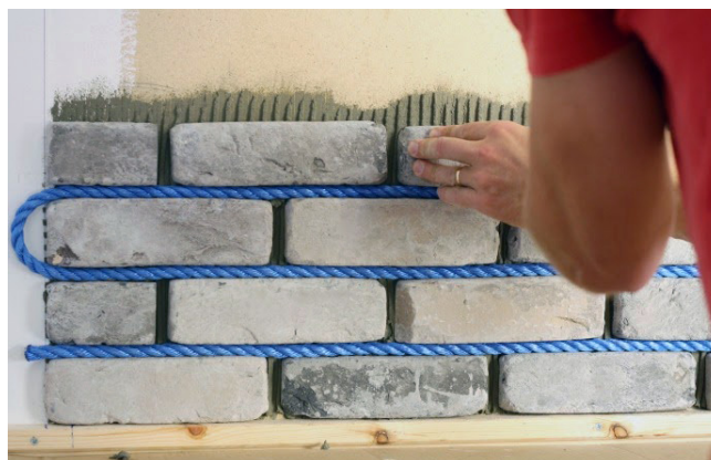
Köysi estää laattojen liikkumisen asennuksen aikana.
